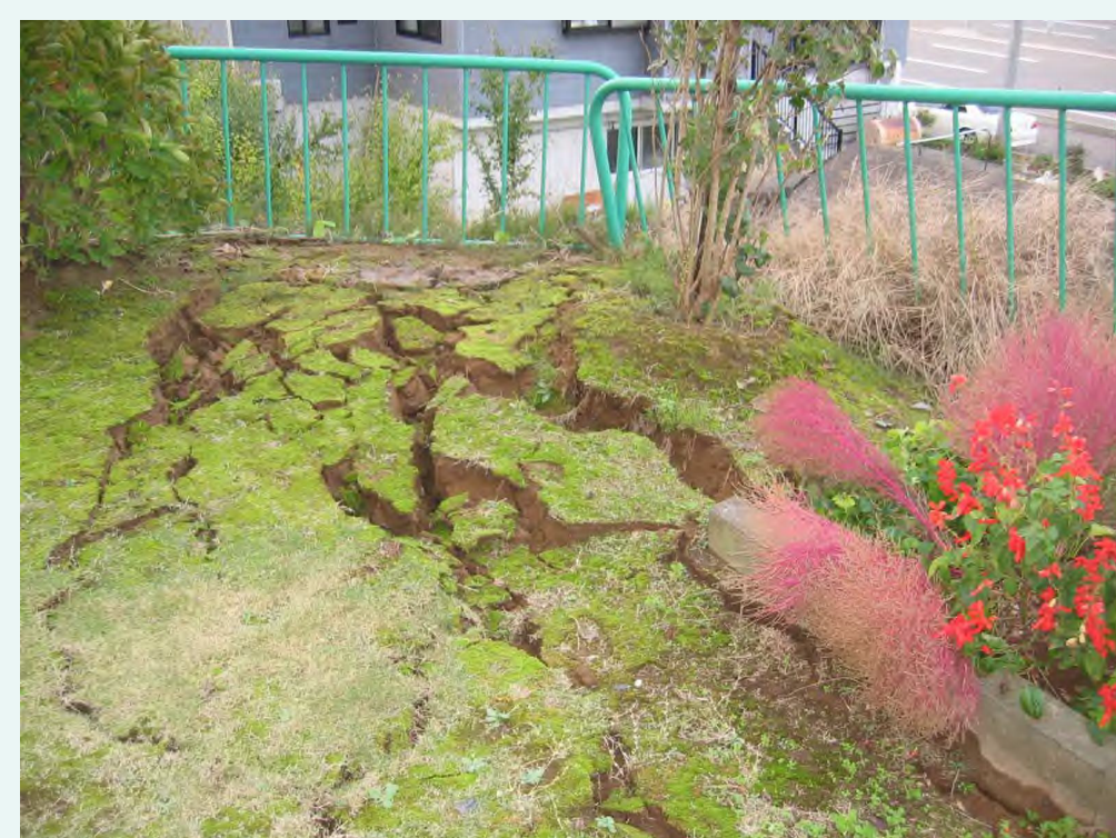
六日市小学校中越地震被災状況写真(崩れた芝生) 撮影日: 2004年10月24日 提供者: 六日市小学校 職員
